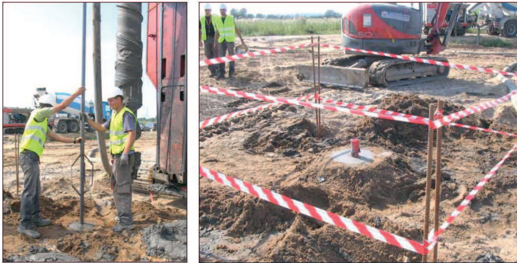
Fig. 5. Insertion of measuring equipment pipe and fully prepared pile. Rys. 5. Wprowadzanie rurki pomiarowej do pała oraz w pełni wykonany pał badawczy
