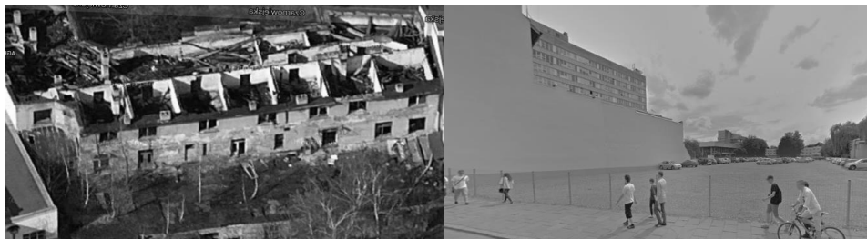
Rys.2. Widok z góry na kompleks pralni chemicznej „Tęcza” przed wyburzeniem, po pożarze, około 2012 [źródło: googlemaps, 06.03.2014] ; Obecnie funkcjonujący parking w miejscu po pralni
