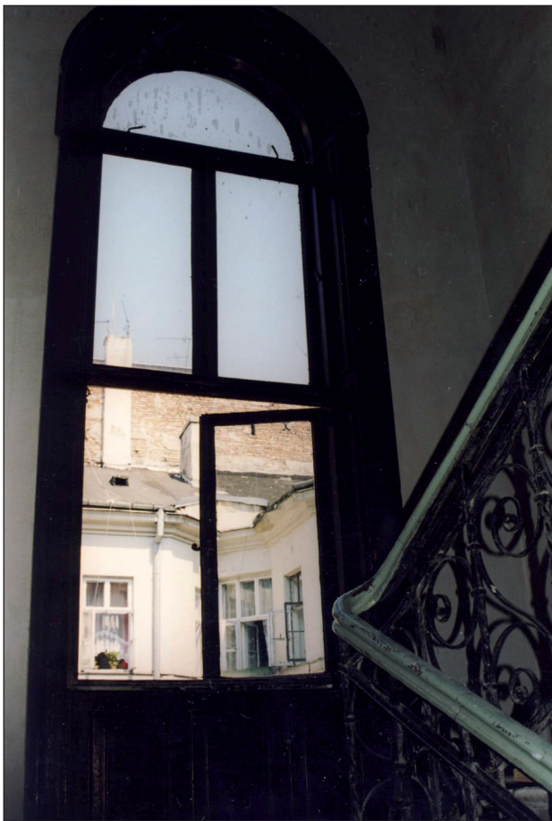
26. Okno klatki schodowej na ostatnim piętrze kamienicy przy ul. Nowogrodzkiej 10 (1892-93).
