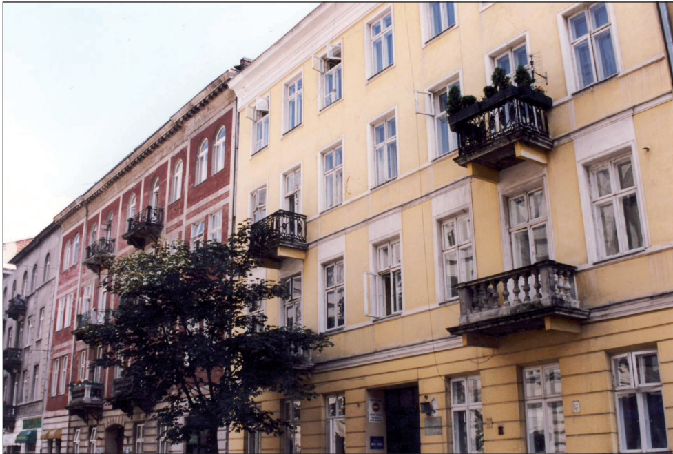
14. Kamienice przy ul. Wilczej 15 z 1885 r. (pierwsza z prawej) i dalej nr 13 i 11 z 1886 r. Utraciły dekorację fasad w czasie II wojny. Okna otwierane na zewnątrz – ościeżnicowe, drzwi balkonowe otwierane do wewnątrz, półskrzynkowe lub skrzynkowe. Nadślepię okien kamienicy przy ul. Wilczej 15 – dwuskrzydłowe. Fot. J. Roguska 2003
