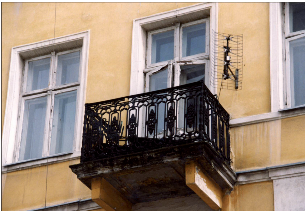
14a. Drzwi balkonowe otwierane na zewnątrz, ościeżnicowe, w kamienicy przy ul. Kruczej 13 (1889-90). Fot. J. Roguska 2003
