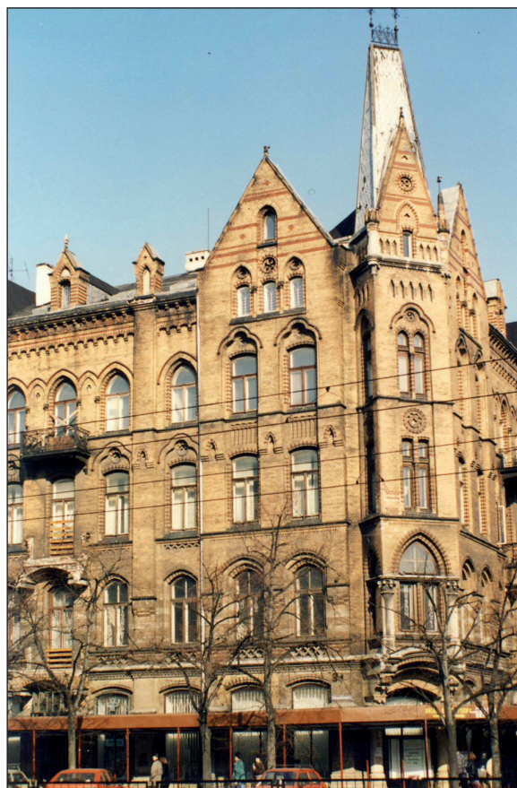
42. Kamienica przy ul. Marszałkowskiej 72 (1897). Fot. J. Roguska 1998, przed remontem 42. Tenement house at 72 Marszałkowska St. (1897). Photo J. Roguska 1998, before renovation
