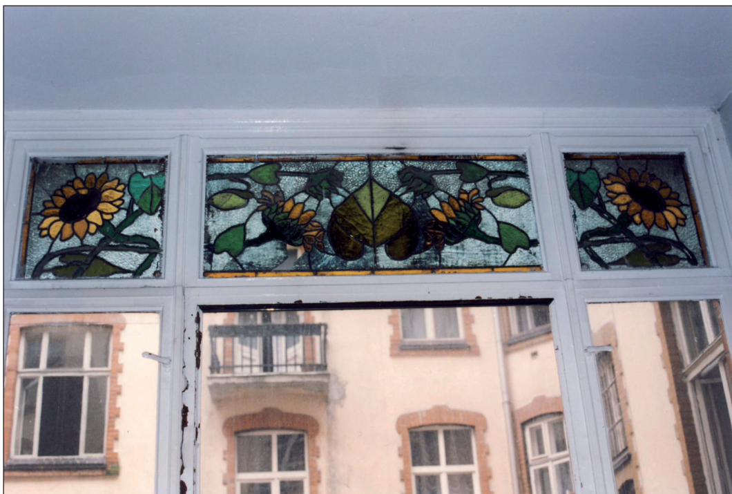
25. Fragment okna klatki schodowej w kamienicy w Alejach Jerozolimskich 51 (1904-06). Fot. J. Roguska 2001 25. Fragment of the staircase window of the tenement house at 51 Aleje Jerozolimskie (1904-06). Photo J. Roguska 2001
