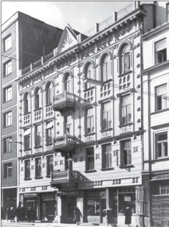
5. Fasada kamienicy przy ul. Chmielnej 30. Stan w roku 1961 roku. Jeszcze z oryginalną stolarką okien, otwieranych na zewnątrz i pierwotną, ciemną kolorystyką zewnętrzną. Fot. A. Zborski, 1961
