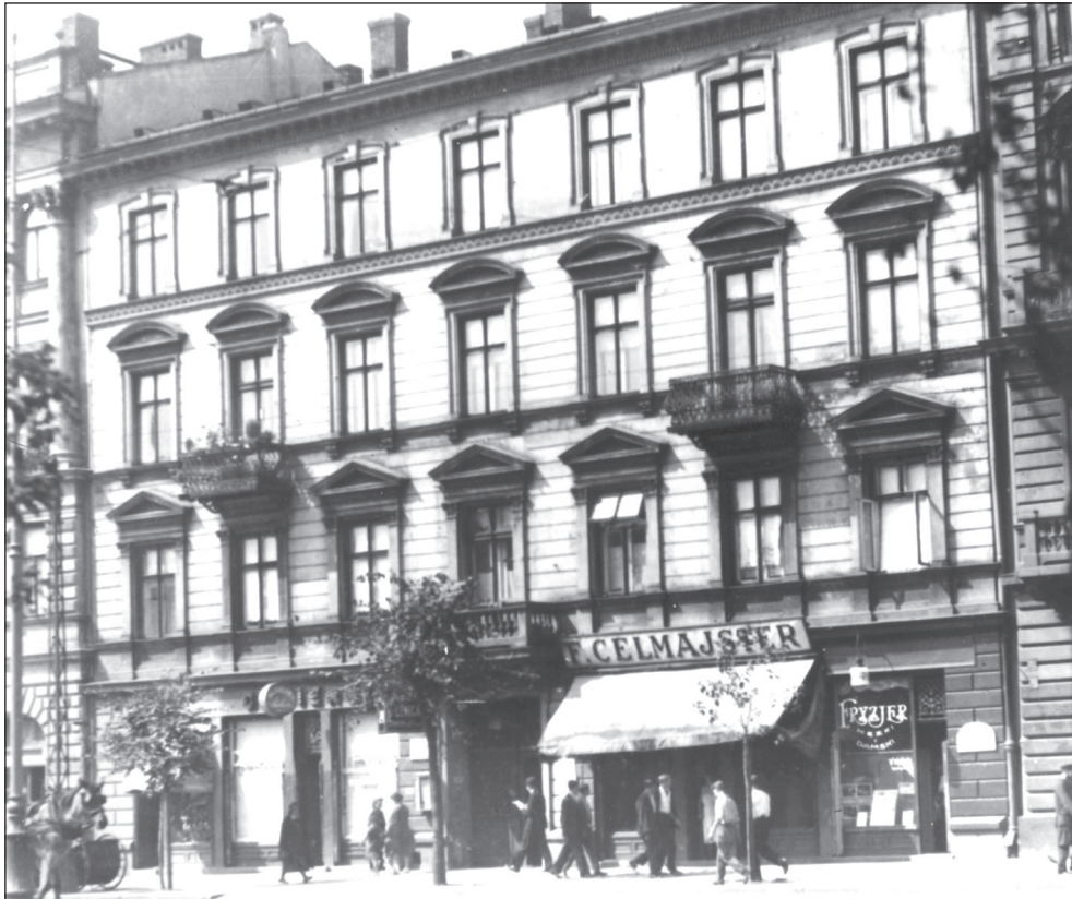
38. Kamienica przy ul. Chłodnej 24 (1875). Źródło: Narodowe Archiwum Cyfrowe 38. Tenement house at 24 Chłodna St. (1875). Source: National Digital Archive
