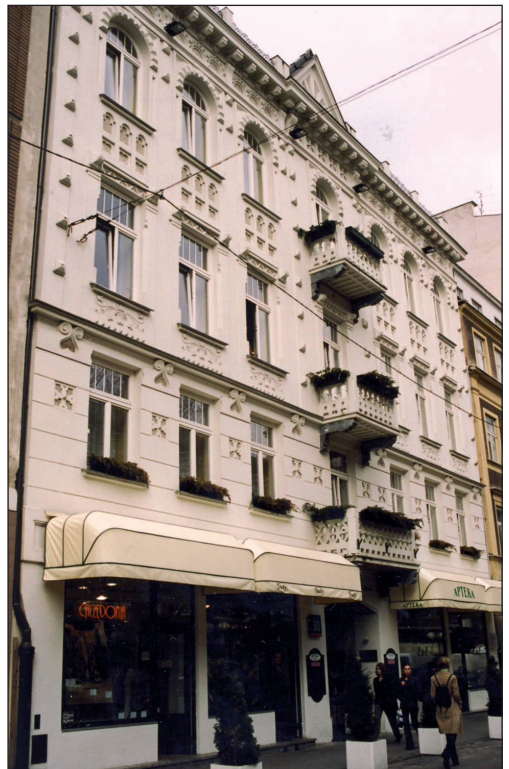
7. Fasada kamienicy przy ul. Chmielnej 30 po generalnym remoncie, z nowymi uchylnymi do wewnątrz oknami, w barwie białej. Fot. J. Roguska 2003 7. Facade of the tenement house at 30 Chmielna St. After general renovation, with new windows opening inwards. Photo J. Roguska 2003
