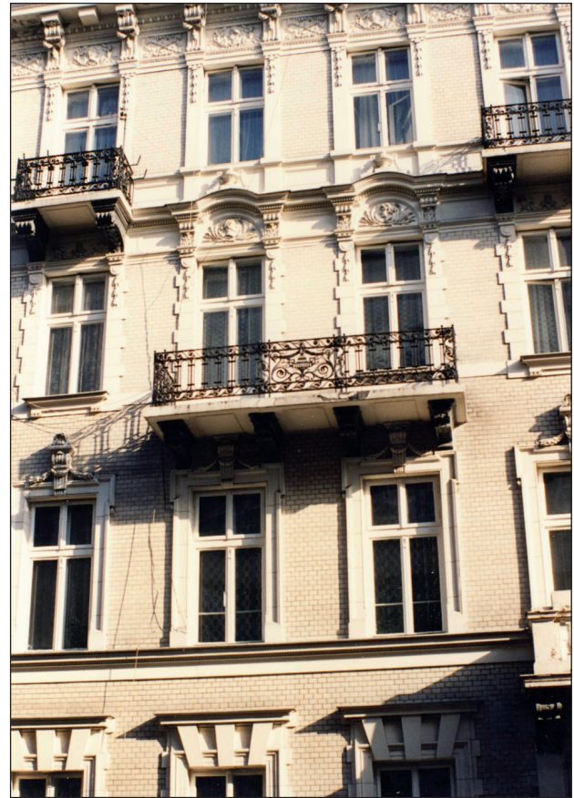
41. Okna kamienicy przy ul. Mokotowskiej 50 (1902). Fot. J. Roguska 2003 41. Windows of the tenement house at 50 Mokotowska St. (1902). Photo J. Roguska 2003
