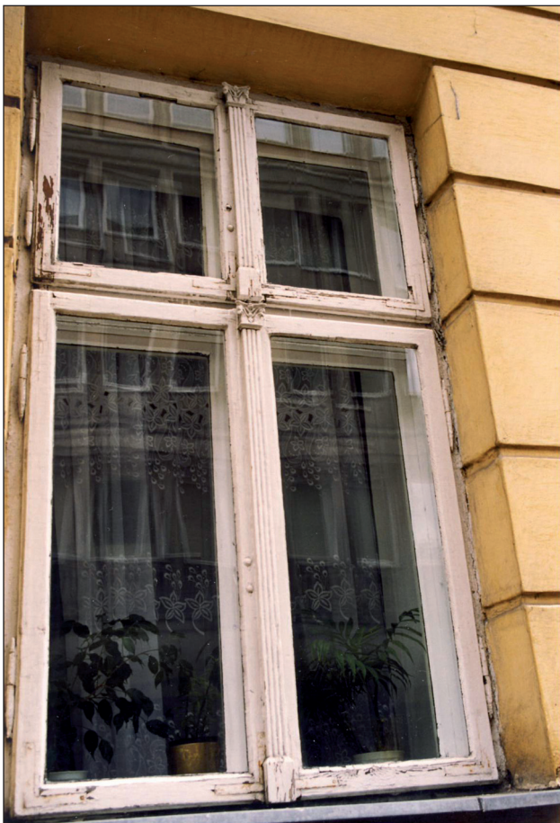
28. Okno kamienicy przy ul. Wilczej 15 (1885). Fot. J. Roguska 2003
