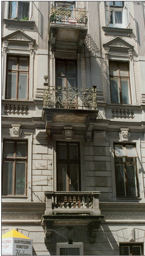
48. Fragment kamienicy przy ul. Wilczej 32 (1897) z zachowaną pierwotną stolarką okienną i ciemną kolorystyką na zewnątrz. Fot. J. Roguska 2002
