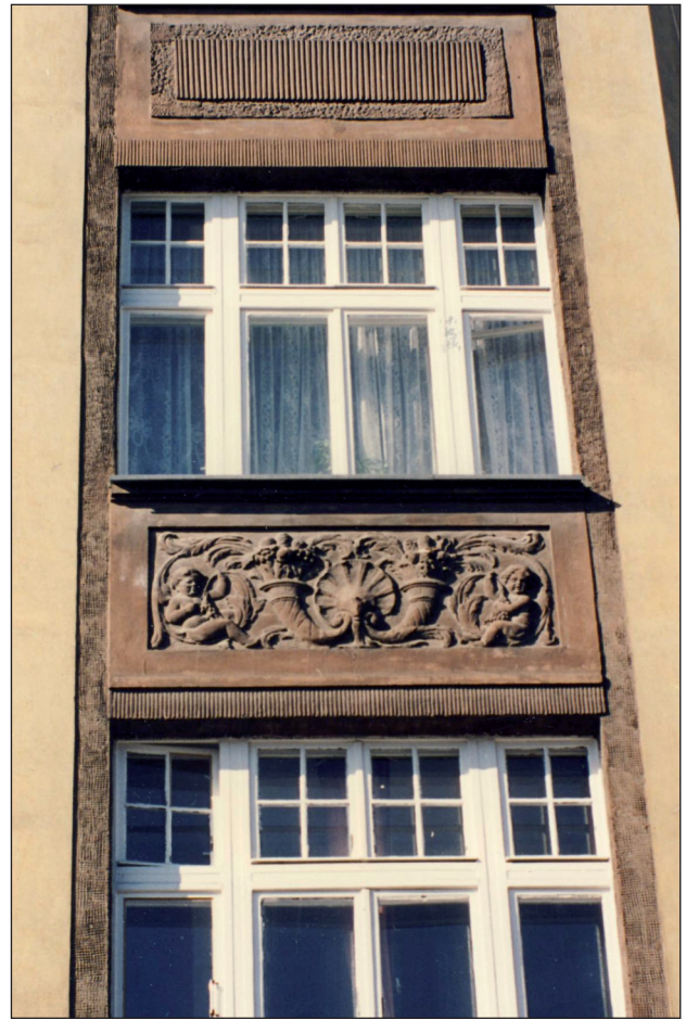
32. Okna w kamienicy przy ul. Flory 1 (1912). Fot. J. Roguska 2003
