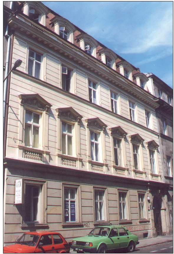
4. Fasada kamienicy przy ul. Jasnej 17. Stan w 2003 r. Fot. J. Roguska 4. Facade of the tenement house at 17 Jasna St. State as of 2003. Photo J. Roguska
