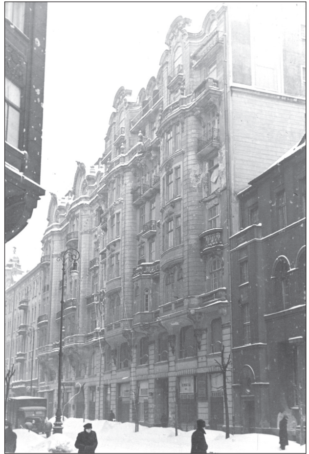
11. Warszawa, kamienice przy ulicy Moniuszki 2a i 4, widok od wschodu. Dom pod nr 4 – projektowany przez J. Handzelewicza, nr 2a – prawdopodobnie - z jego udziałem. Zdjęcie z 1940 r. Źródło: Archiwum Mazowieckiego Wojewódzkiego Konserwatora Zabytków (AMWKZ). Zbiór Referatu Gabarytów 11. Warsaw, tenement houses at Nos. 2A and 4 Moniuszki Street, view from the east (1940). House no 4 - design by J. Handzelewicz, no 2a – probably with his participation. Source: Mazovian Voivodeship Heritage Protection Archives (AMWKZ), Volumetric Section collection
