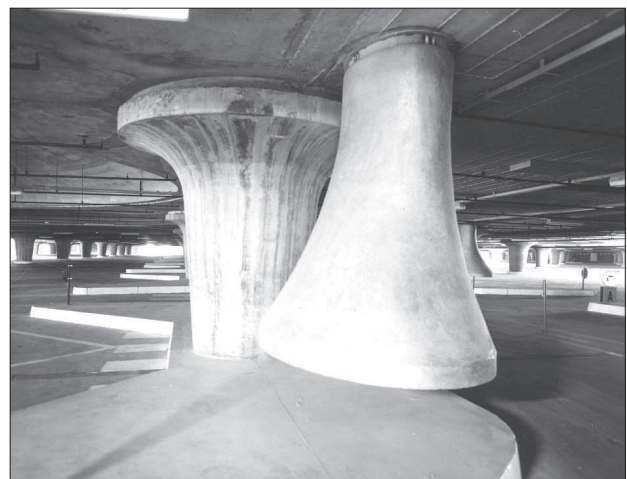
43. L. Moretti, podziemny parking Villa Borghese (1965-1972), filar w kształcie grzyba i czerpnie powietrza. Archivio Centrale dello Stato, Rzym
