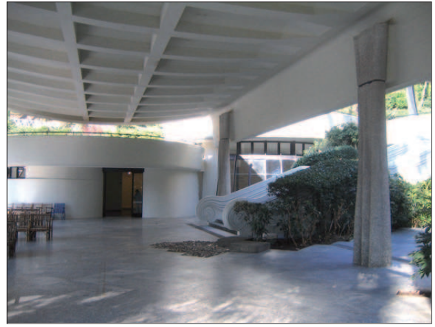
48. L. Moretti, Przebudowa kompleksu uzdrowiskowego „Fonti Bonifacio VIII” w Fiuggi, 1963-1969, konstrukcja „Arabskiego Namiotu”. Archivio Centrale dello Stato, Rzym
