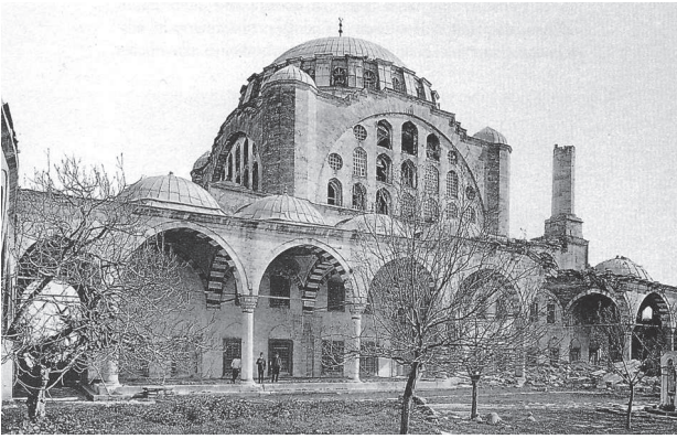
15. Mihrimah Camii, zniszczenia dokonane przez trzęsienie ziemi w 1894 r.; za: D. Barillari, Raimondo D'Aronco , Rzym-Bari 1995
