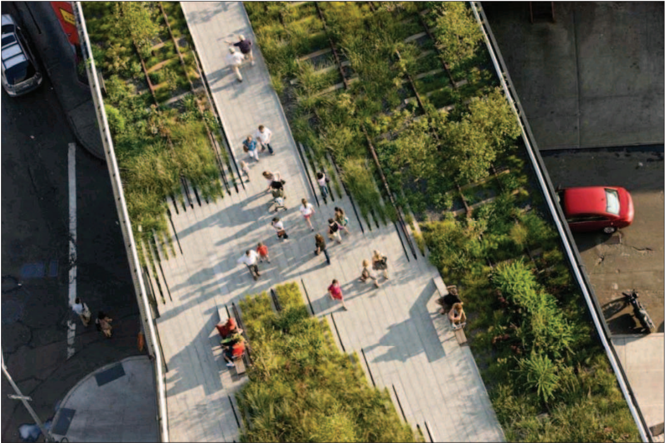
6. Park High Line. Źródło: M. Fisher, s. 34 6. Park High Line. Source: M. Fisher, p. 34
