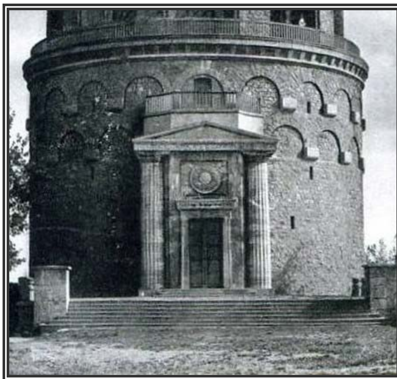
Ryc. 5. Kolumny podtrzymujące trójkątny portal
