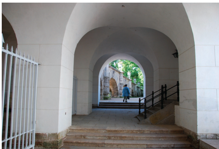
Ryc. 11. Wiszący Ogród, stan po konserwacji (fot. 2010, M. Wilczkiewicz)
