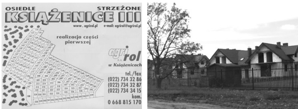
Fot. 2. Osiedle deweloperskie „Książenice”. Brak przestrzeni publicznych, terenów usługowych, wydzielono małe działki budowlane, zespół został odgradzony od otaczającej przestrzeni, co kontrastuje z zabudową wiejską
