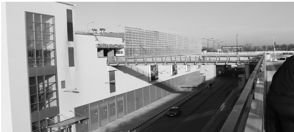
Fot. 16-17. Fasada Galerii Krakowskiej od strony dworca PKP
