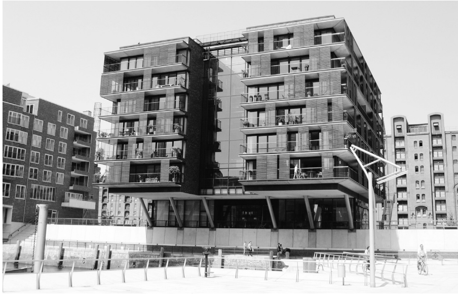
Fot. 13. System zabezpieczenia przeciwpowodziowego na najniższej kondygnacji budynków
