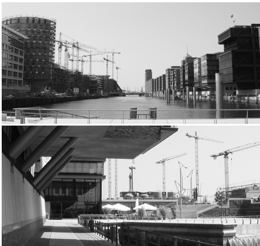
Fot. 10-11. 10) Budynki biurowe i mieszkaniowe w Kwartale Dalmannkai, 11) promenada wzdłuż basenu portowego i realizowana przestrzeń publiczna tarasy Magellana 2008
